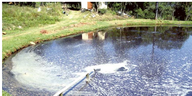
Antes: No tratamento com alumínio as impurezas da água formam um lodo que contém componentes que não podem ser reciclados
