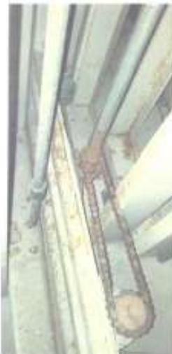
Foto 4 – Parte móvel do arquivo com a corrente oxidada.
