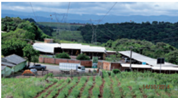
Figura 5 - Construção irregular na faixa sob as LTs
