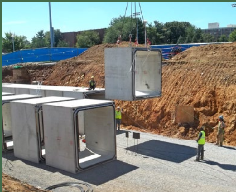
Instalação de galerias de caixas de concreto pré-moldado para criar um tanque subterrâneo de retenção de águas pluviais
