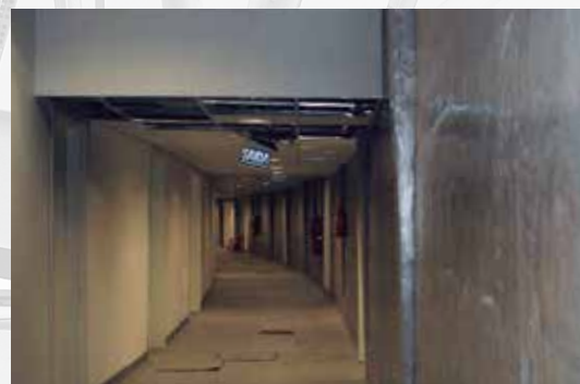
Mantida escondida antes das novas obras, a parede da arquibancada inferior, Geral, servia apenas para dar sustentação a esse setor. Com a reforma, ela foi preservada e se encontra, hoje, em um corredor de circulação
