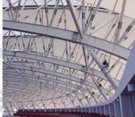
A cobertura metálica é o grande diferencial da obra. Conforme a vice-presidente do Internacional, Arq. Diana Oliveira, a estrutura representa 33% do investimento total da obra e garante mais conforto e segurança aos torcedores
