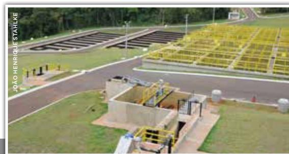
Na Estação de Tratamento de Esgoto Esperança, em Londrina, são utilizados reatores com processos anaeróbicos, sem distribuição de ar, de fácil construção e operação, e de baixo custo. É realizado ainda o pós-tratamento para dar mais qualidade de efluente, buscando sempre índices abaixo de 20, 25 gramas de DBO por litro
