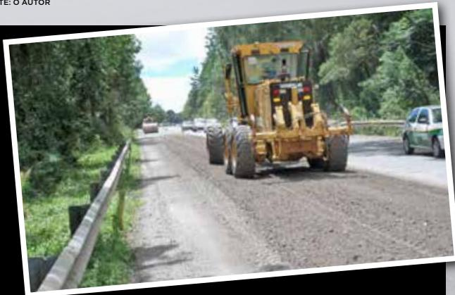
**Obras:** Execução de Recuperação da Rodovia RSC 470, Trecho: Veranópolis - Nova Prata, e ERS 324, Trecho: Nova Prata - Nova Araçá.
