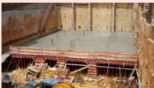
Figura 2. Trecho da primeira laje concretada.
