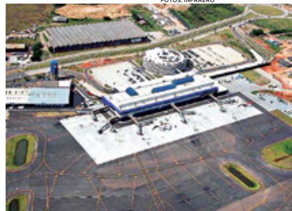
Terminal 1, construído na década de 1990, conta com shopping, praça de alimentação e várias lojas
