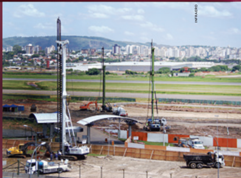
Obras do aeroporto
