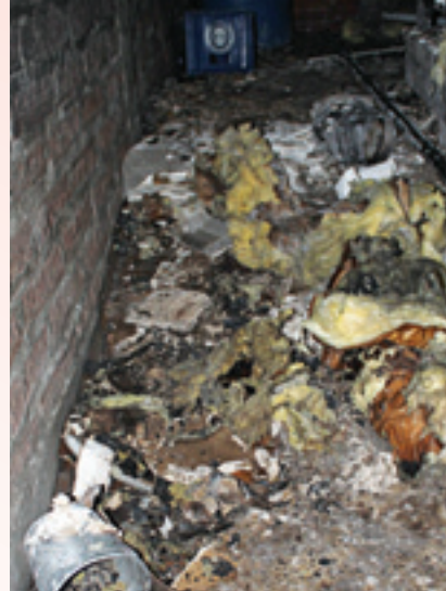
As paredes laterais e de fundo da boate ficavam justapostas às paredes dos prédios vizinhos, não havendo janelas nem outras saídas disponíveis. O prédio era totalmente fechado em todo o seu perímetro, inclusive na fachada, com exceção das referidas portas frontais justapostas de acesso e saída
