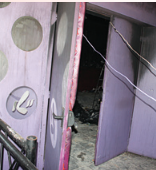
A Boate Kiss apresentava somente uma saída de emergência, que era a mesma de acesso a ela, formada por duas portas com vão de luz de 1,75 m de largura e outra com 1,6 m, almofadadas internamente com espuma e couro sintético, e entre elas uma divisória central fixa de 1,0 m. Com o revestimento acústico inadequado aplicado e altamente tóxico, que em questão de minutos mata uma pessoa, o número de saídas alternativas deveria ser maior
