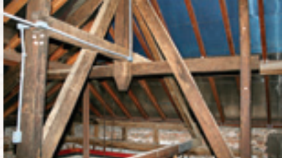
Todas as instalações hidráulicas e elétricas tiveram de ser revistas
