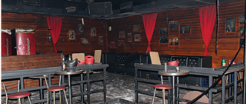
O interior do prédio apresenta vários ambientes interligados por passagens. Além disso, havia barreiras físicas de guarda-corpos metálicos na frente dos bares para organizar o seu acesso e antes da porta de saída da edificação e espuma no teto
