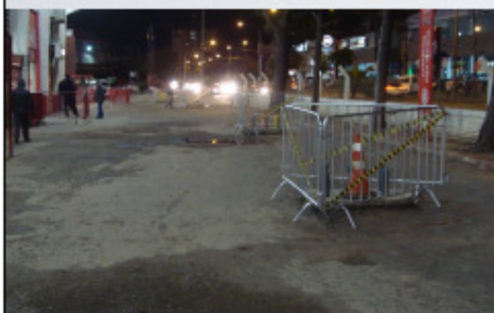
LIMPEZA E ISOLAMENTO
