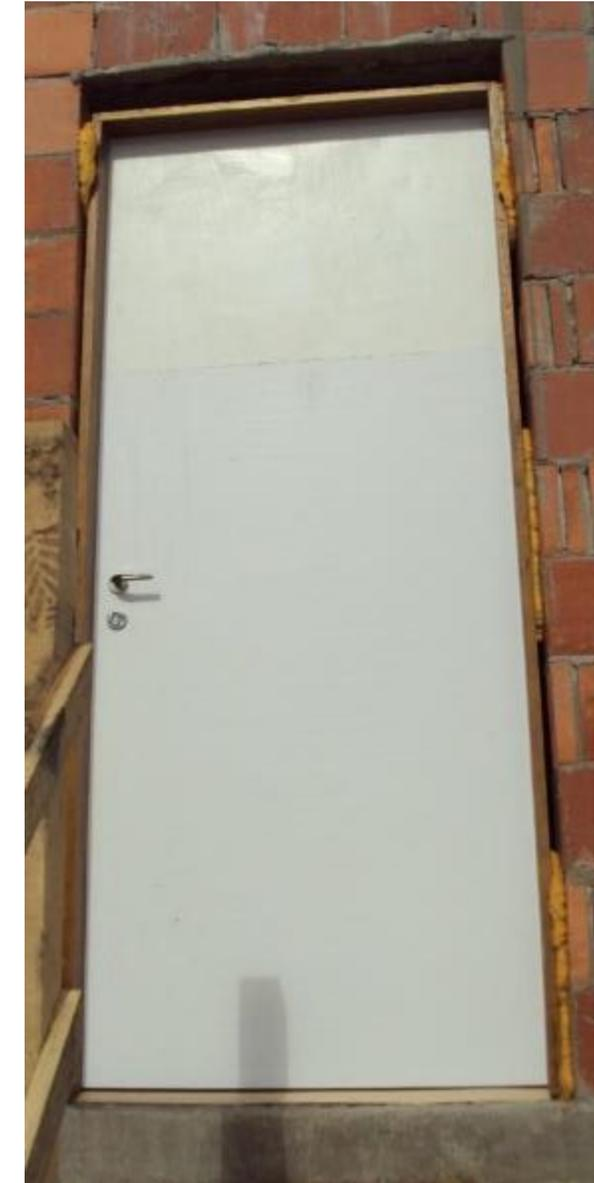
As **frestas** provocadas pela falta de qualidade do elemento construtivo ou sua instalação, **diminuem** substancialmente a **resistência sonora** de um fechamento.
