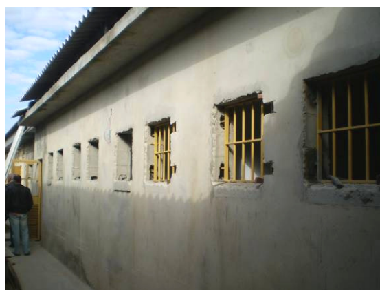
Colocação de grades e janelas de grades internas e externas nas áreas de apoio e administração
