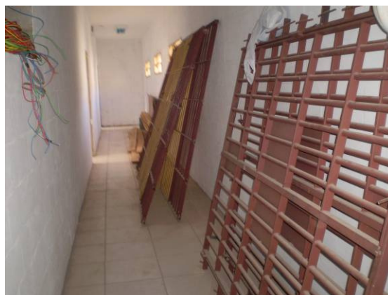
Vista da área de apoio e administração – em obras em andamento
