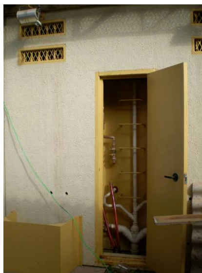
Detalhe das portas internas – celas, e portas externas – shaft das instalações
