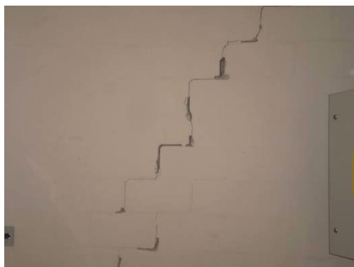
Vista da circulação dos agentes – detalhe do trincamento das elevações de alvenaria de blocos
