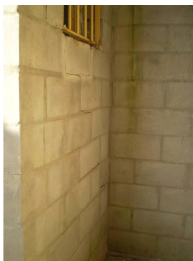
Vista interna e externa do sanitário do pátio dos presos – detalhe do trincamento da alvenaria de blocos que dá acesso ao pátio de manutenção
