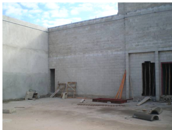
Vista do pátio dos presos – inexistência de guarida de observação
