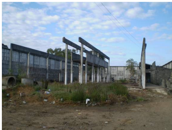
Vista Aérea da Penitenciária Modulada Estadual da Charqueadas Detalhe da Obra Inacabada do Hospital Penitenciário
