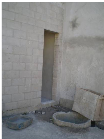
Vista interna e externa do sanitário do pátio dos presos – detalhe do trincamento da alvenaria de blocos que dá acesso ao pátio de manutenção
