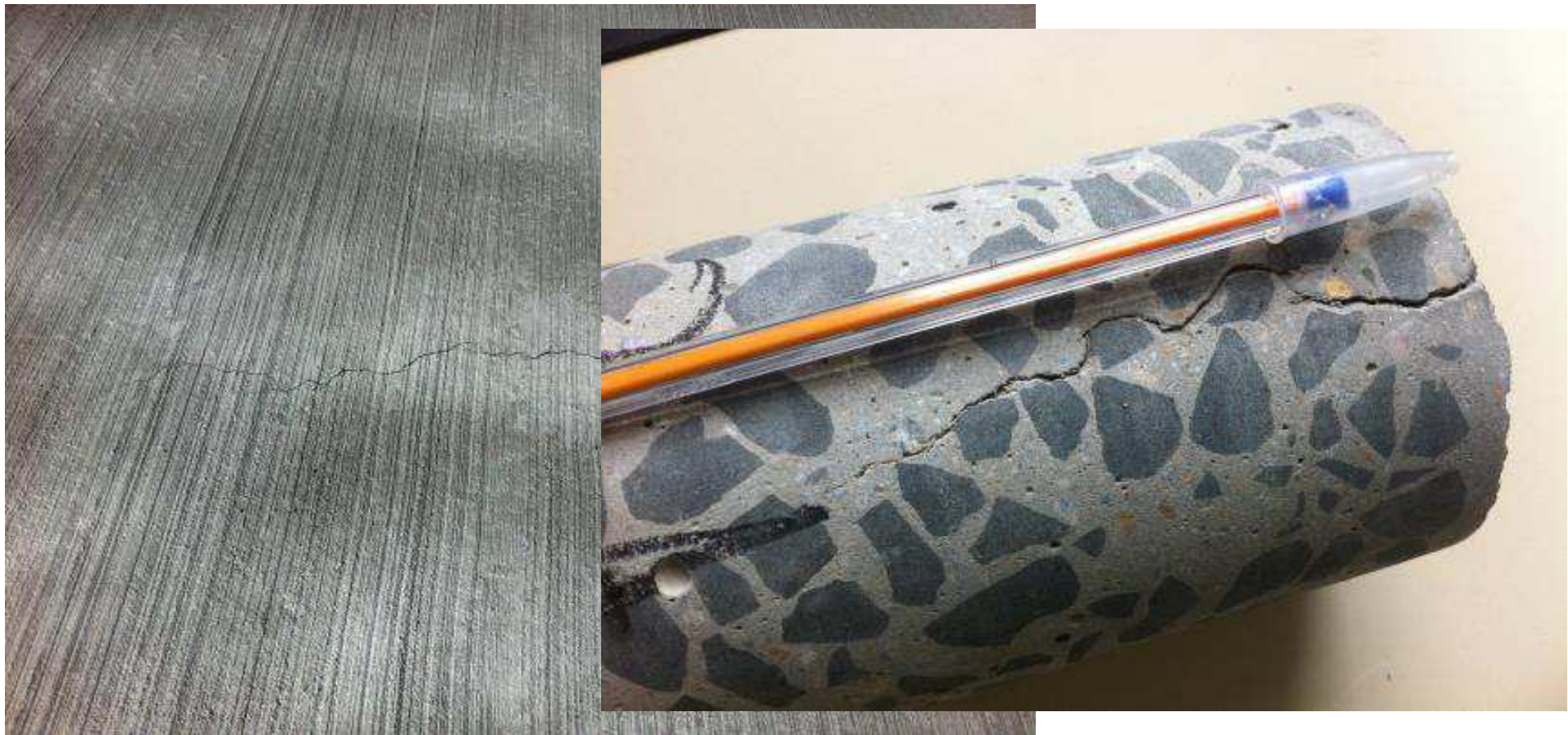
Piso de aeropuerto Salgado Filho Internacional – Porto Alegre / BR
