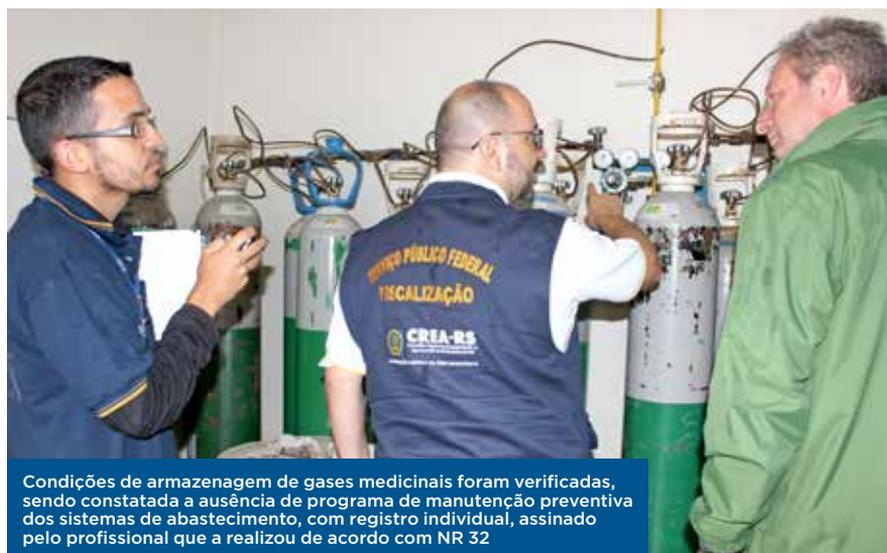
Condições de armazenagem de gases medicinais foram verificadas, sendo constatada a ausência de programa de manutenção preventiva dos sistemas de abastecimento, com registro individual, assinado pelo profissional que a realizou de acordo com NR 32
