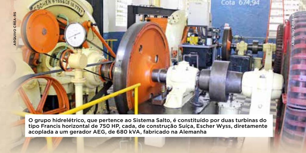
O grupo hidrelétrico, que pertence ao Sistema Salto, é constituído por duas turbinas do tipo Francis horizontal de 750 HP, cada, de construção Suíça, Escher Wyss, diretamente acoplada a um gerador AEG, de 680 kVA, fabricado na Alemanha
