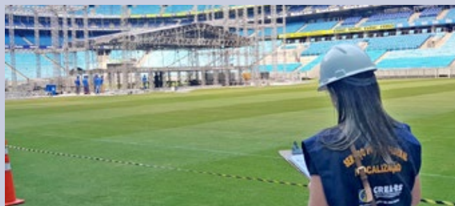
Ação na Arena do Grêmio, que recebeu o show do Roberto Carlos, verificou as presenças de profissionais e empresas legalmente habilitadas envolvidas na montagem das estruturas metálicas em geral e do palco, instalações elétricas, Plano de Prevenção e Proteção Contra Incêndio (PPCI) e sonorização
