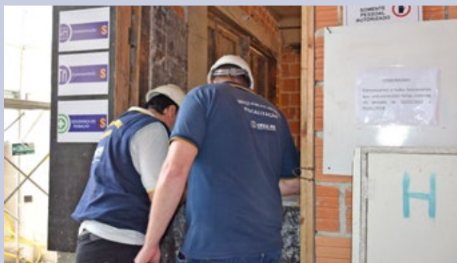
Blitz de Fiscalização na Capital gaúcha com foco em obras civis nas regiões das Zonas Sul, Norte e Centro verificou 230 canteiros de obras, gerando 257 relatórios de fiscalização e 91 TRDPs
