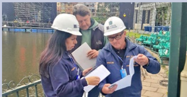
Blitz de fiscalização nas montagens de diversas estruturas da programação do Natal Luz de Canela e Gramado. Foram verificados 75 empreendimentos e gerados 19 Termos de Requisição de Documentos e Providências e um auto de Infração por exercício ilegal nos municípios de Gramado e Canela
