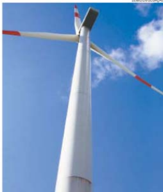
Torre semelhante as 75 que serão instaladas em Osório
