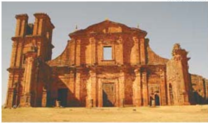
...Ruínas de São Miguel.
