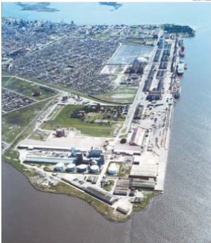
Canais de obras está sendo implantado no porto de Rio Grande, acima
