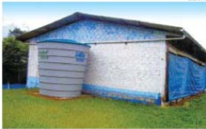
Cisternas, como a da foto, armazenam água da chuva recolhida por calhas
