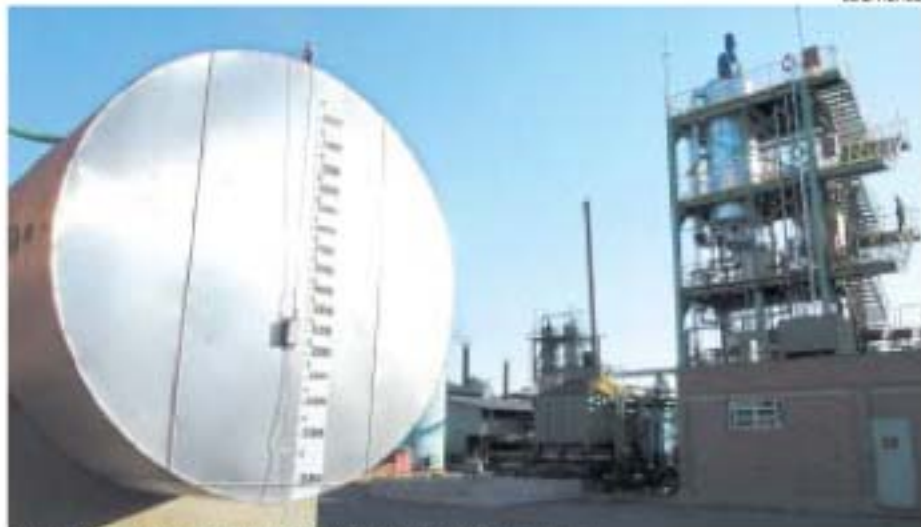
Evaporador de petróleo, à dir. na foto, onde o óleo básico é separado das impurezas
