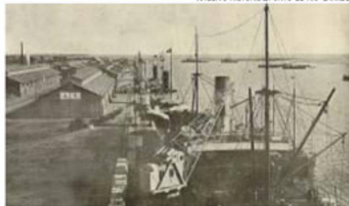
Foto da época da construção dos molhes
