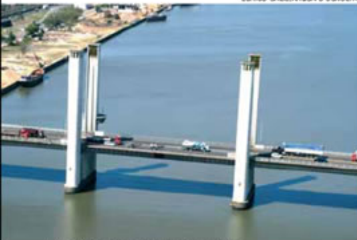
Vão móvel, que eleva 400t a uma altura de 24m
