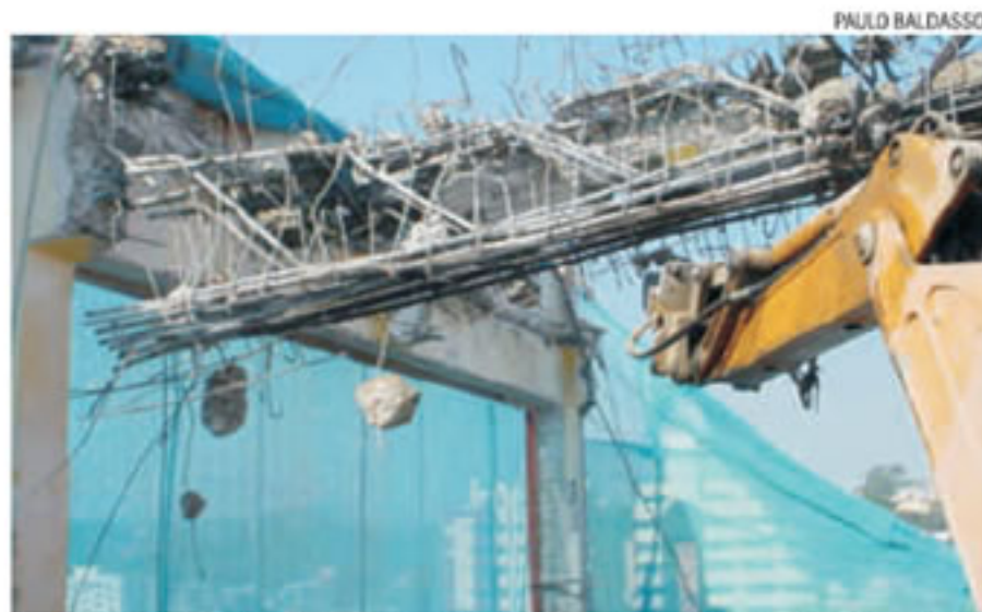
Após a retirada da alvenaria de vedação, os pilares internos foram tombados para o interior da edificação demolida
