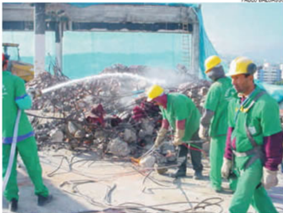
Operários, devidamente protegidos e equipados com caneleiras, luvas de cano longo, avental e óculos, cortam as barras de armaduras do concreto. Eles mantêm o entulho irrigado para conter a poeira
