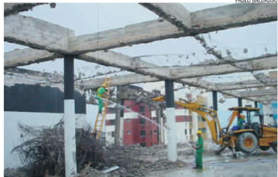
O prédio de concreto armado possuía uma área construída de 14.520 m 2 , sendo projetado para abrigar as oficinas gráficas das Livrarias Globo, nos anos 60
