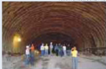
Diretores do CREA-RS visitam as obras do túnel da BR-101
