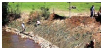
4. Instalação de uma esteira viva após a remodelagem do talude
