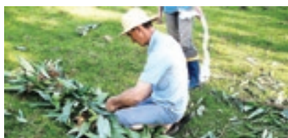
3. Detalhe da preparação dos feixes vivos utilizados para vegetar a face exposta da palificada dupla
