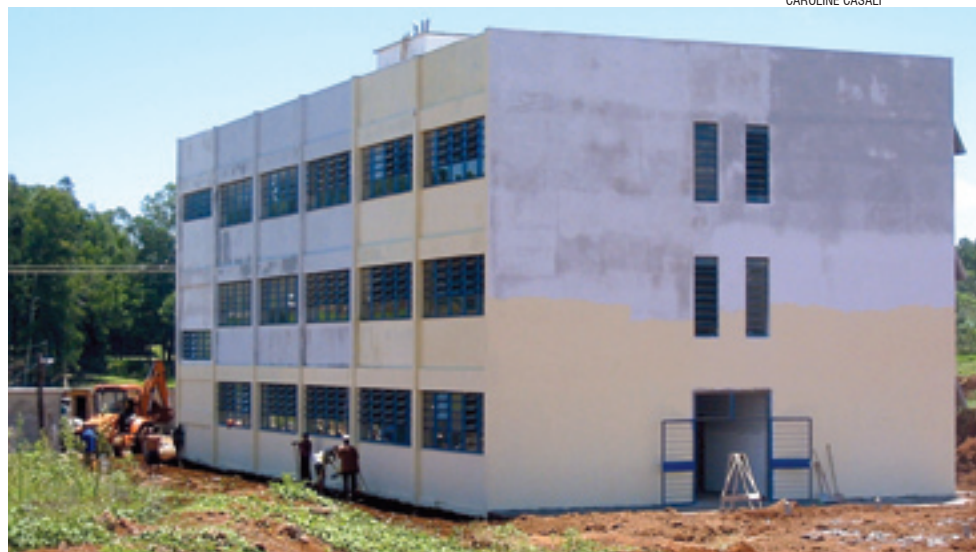
Construção do primeiro prédio da Ufsm/CesnoRS – Campi Frederico Westphalen
