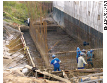
Obras de bloco do barrilete
