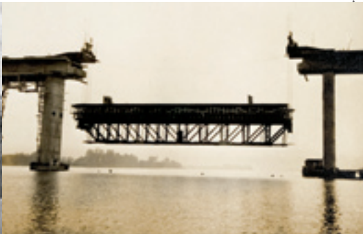
Construção da Ponte
