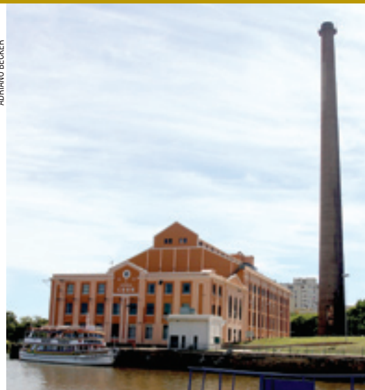
Gasômetro, visitado por centenas de pessoas que procuram formas de lazer
