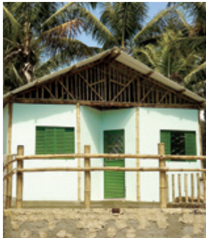
Habitação popular construída em 2003 em Maceió – Sistema de Esterilha
