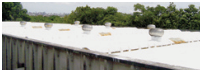
Telhado com a Pintura Protetora Elastomérica, após a aplicação do Poliuretano
