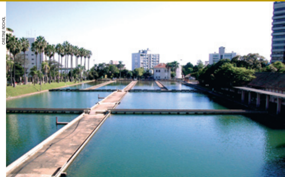
Estação de tratamento do Moinhos de Vento
