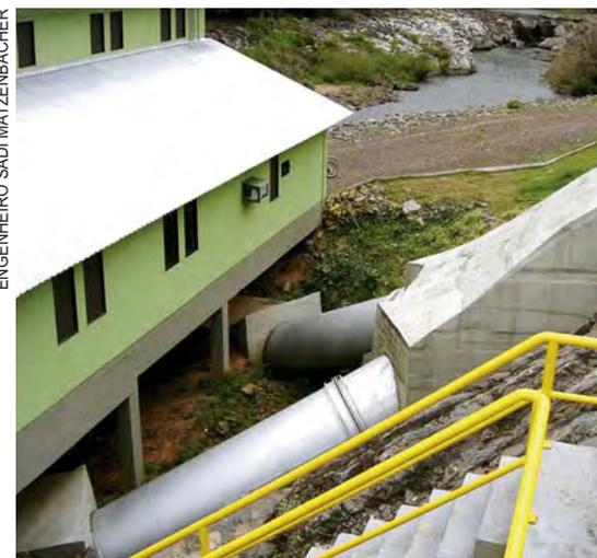
Exemplo de tubulação que conduz a vazão de água desviada dos rios para a casa de máquina de uma PCH
