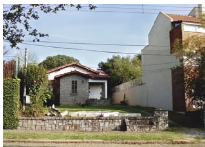
Levou gato por lebre: era só para casas, agora tem edifício fazendo sombra
