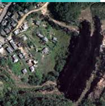
Pedreira predatória abandonada: obstruindo o urbanismo, danificando o meio ambiente e criando riscos à comunidade
