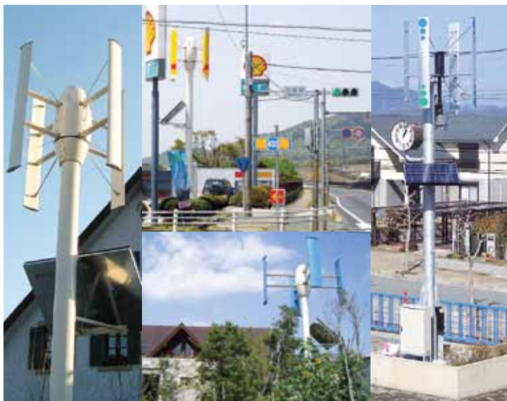
Microeólica Gentle Breeze funcionando no Japão
