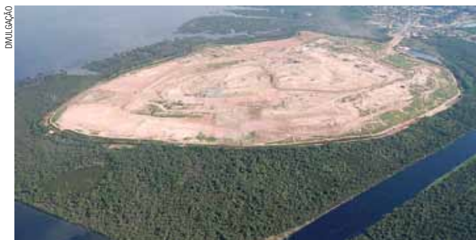
Depois de muitos anos de tratamento, o aterro de Gramacho encontra-se totalmente recuperado, como mostra a foto de setembro de 2009
