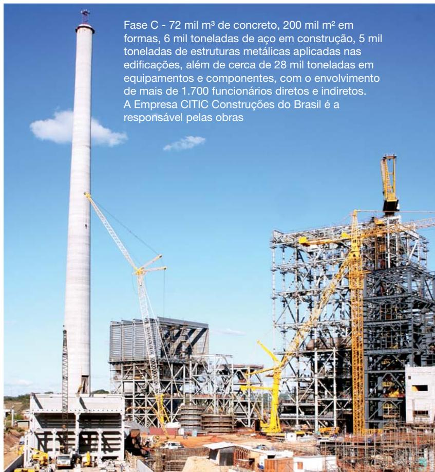
Fase C - 72 mil m<sup>3</sup> de concreto, 200 mil m<sup>2</sup> em formas, 6 mil toneladas de aço em construção, 5 mil toneladas de estruturas metálicas aplicadas nas edificações, além de cerca de 28 mil toneladas em equipamentos e componentes, com o envolvimento de mais de 1.700 funcionários diretos e indiretos. A Empresa CITIC Construções do Brasil é a responsável pelas obras
