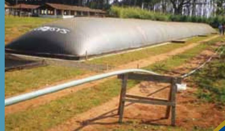
Biodigestor instalado na Etec
