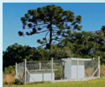
Estação sismográfica de Canela em fase final de instalação. O sensor está instalado dentro da caixa da esquerda, o registrador e transmissor, no abrigo maior da direita, com painéis solares no teto
