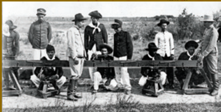
Engenheiros Militares da CCGB operando o Basímetro Troughton, antiga ferramenta utilizada para medições de bases geodésicas (1906)
