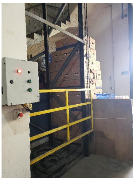
Elevador não atende à NBR14712:2013, NBR15597:2010 e NR11 e não foi apresentada a documentação
