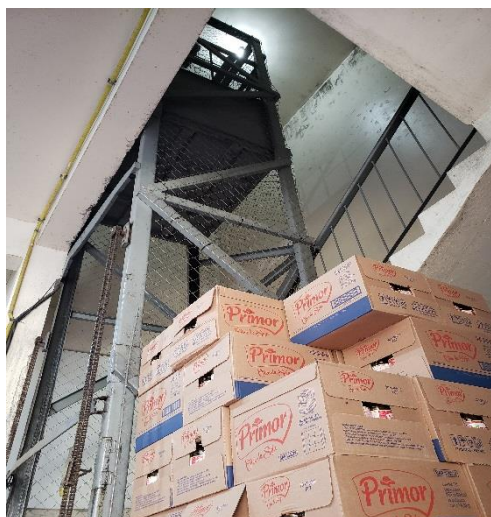
Elevador não atende à NBR14712:2013, NBR15597:2010 e NR11 e não foi apresentada a documentação
